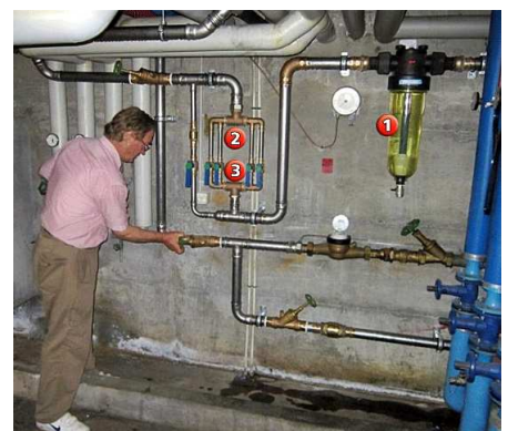
Anlage für ein Wohnhaus mit 35 Wohnungen. Die Punkte bedeuten: 1: Filtrierung; 2: Reaktor; 3: Verfeinerung.
