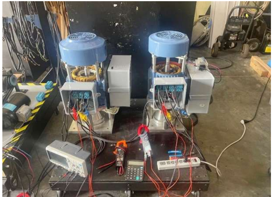
Die Demo-Anlage, die Holcombs für die Präsentation in Blaubeuren vorbereitet haben: ein 10-kW- und ein 15-kW-ILPG in Serie geschaltet.
