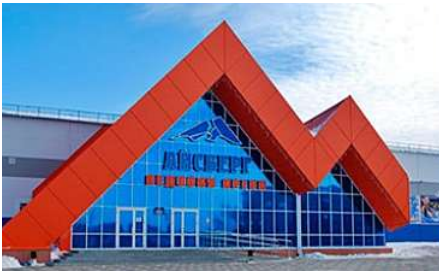
gEis-Arena, Belgorod/RU, Ab April 2018 Einsatz eines 250-kW-NRG-Systems, Einsparung: 14%.
