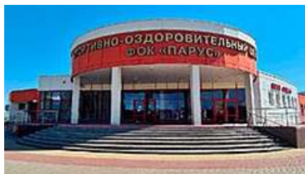
Sportzentrum "Parus", Belgorod/RU, ab August 2019 Einsatz eines 100-kW-NRG-Systems, Stromeinsparung: 11,5%.
