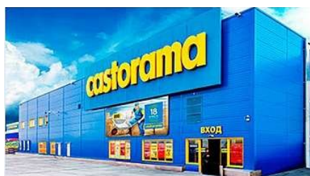
Hypermarket, St. Petersburg/RU, Ab Juli 2013, Einsatz eines 500-kW-Systems, Einsparung: 12%.
