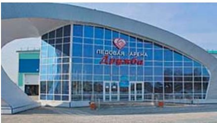
Firma JSC LIT-PHONON, Moskau/RU Ab Juni 2016, Einsatz eines 550-kW-NRG-Systems, Einsparung: 8,54%.
