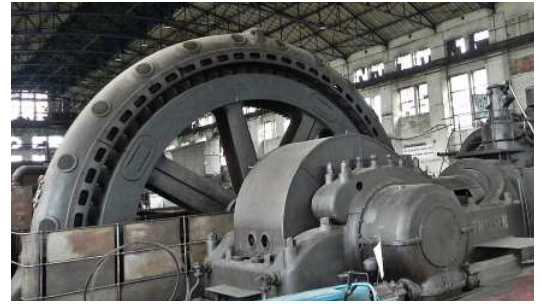
Schwungrad der Gasdynamomaschine 3 in der Gasmaschinenzentrale.
