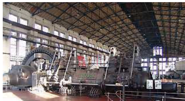
Blick in die Halle der Gasmaschinenzentrale.
