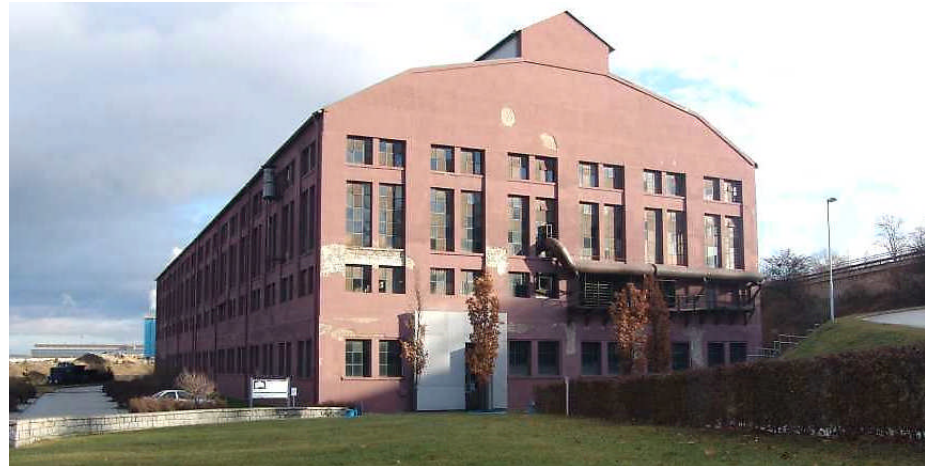
Die Gasmaschinenzentrale Unterwellenborn ist ein Zeuge vergangener deutscher Industriegeschichte, doch auch Ort des Studiums und der Erforschung neuer Ansätze.
