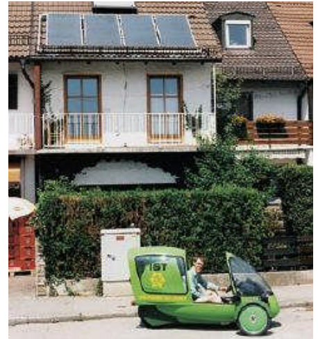
Haus in München-Ramersdorf mit Sonnenkollektoren, zwei Photovoltaikanlagen, einer Niedertemperaturheizung und WhisperGen-Anlagen.
