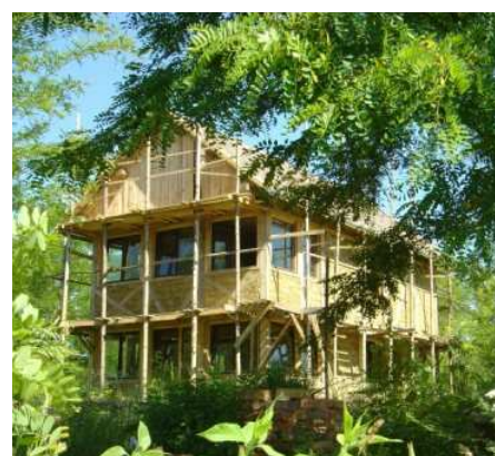
Ein selber gebautes Haus aus Naturmaterial - noch im Rohbau.
