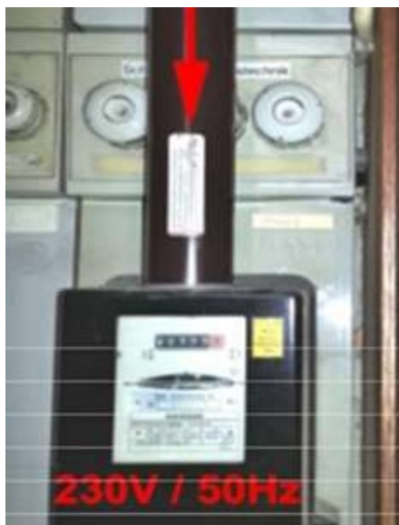
Abbildung 6: Foto eines senkrecht peilend auf einen Stromzähler gerichteten MHRs.
