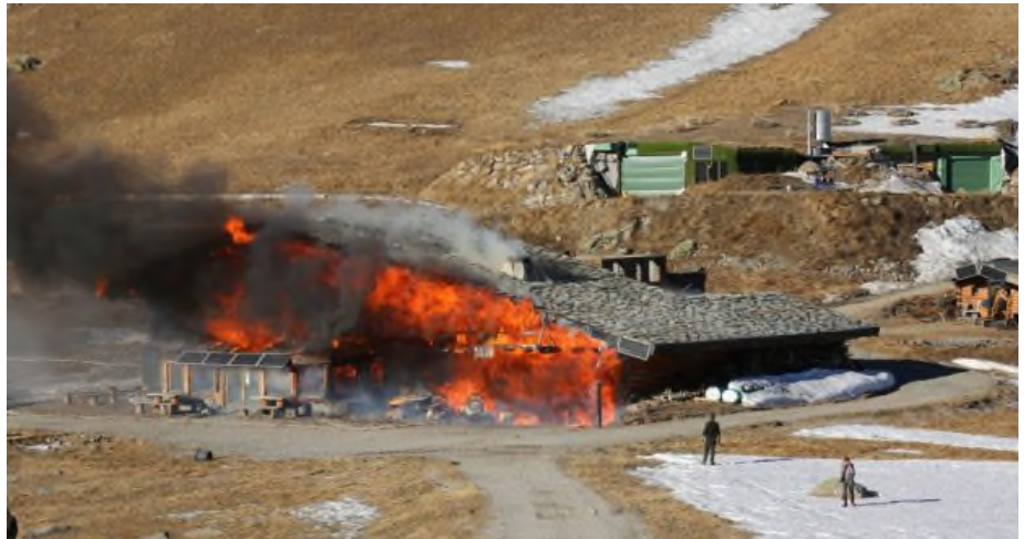
Das Hauptgebäude von Fabrice Andrés autonom betriebenen Ökozentrum Alpe d'Huez wurde ein Raub der Flammen.
