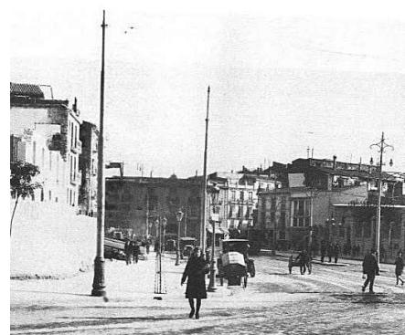
Strassenbild um 1905 in Valencia, nachdem Kabel auf die drahtlosen Antennen angebracht worden waren. Die dünnen Kabel sind im Foto kaum sichtbar.
